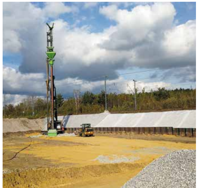
LRB 155 mit RSV-Anlage stopft von der Baugrubensohle
