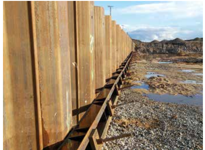
Der Baugrubenverbau ist komplett hergestellt – der Aushub der Baugrube kann beginnen
