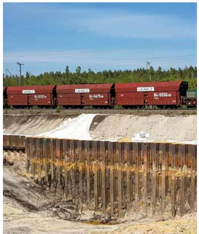
Freigelegter Verbau in Funktion
