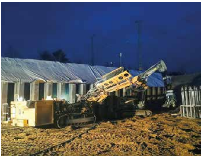
Bohrgerät KLEMM KR 806 der Firma Himmel und Papesch GmbH bei der Herstellung der Rückverankerung
