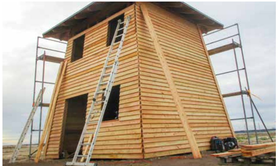
Beobachtungspunkt „Vogelhäuschen“ (im Bau)
