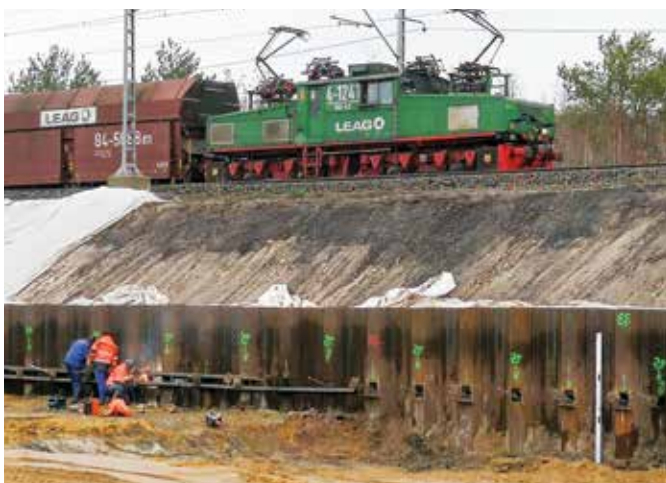
Herstellung der Gurtung
